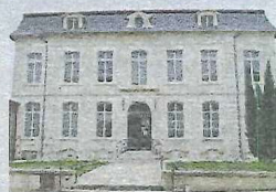
La façade côté rue Marcel-Jambon a été entièrement ravalée. PHOTO L.
